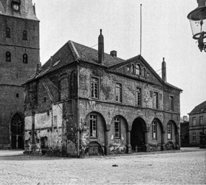
Bis zum Abriss im Jahr 1910 stand direkt vor der St. Remigius-Kirche dieses Rathaus- und Gerichtsgebäude. Seine Ursprünge reichen bis 1384 zurück.
