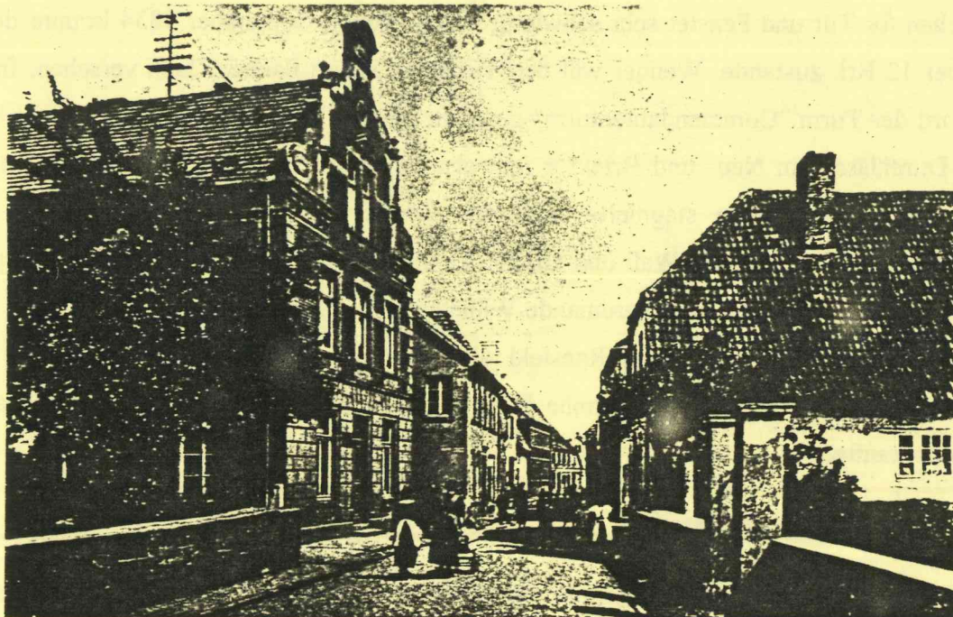
Brinkstraße um 1900 mit dem Hause Ohters - jetzt Baustelle
